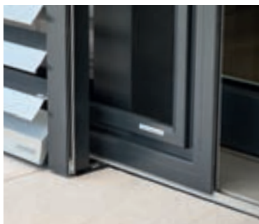
Freitragende Führungsschiene für Insektenschutz Schieberahmen
