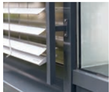
Führungsschiene mit Abstandhalter
