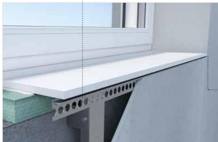
**Einbau bei Betonparapet mit Trockenbauvorsatzschale**
